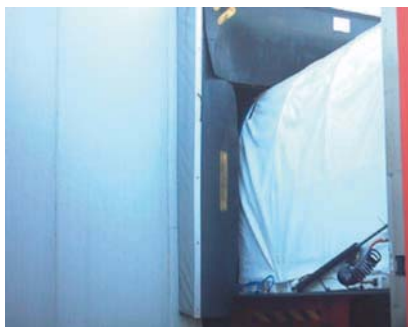
Тенд и погрузочная рампа обеспечивают сухую погрузку.
